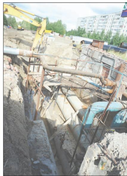
появились пустоты под дорогой. Когда мы начали работу по проколу, произошла подвижка грунта, что и привело к обрушению дорожного покрытия. Нам пришлось перекрывать движение. Хорошо, что проблема обнаружилась именно сейчас. На данный момент две гильзы продвинули полностью, сейчас делаем третью под водопровод. Мы восстановили дорожное покрытие, но пока без асфальтирования. После окончания производства работ покрытие будет восстановлено в полном объёме.
